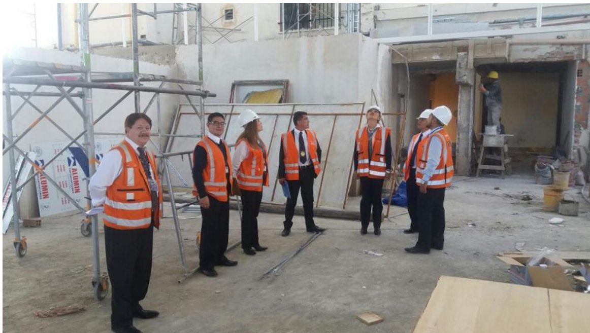
FOTOGRAFÍA VERIFICACIÓN DE LA AMPLIACIÓN Y REMODELACIÓN DEL AEROPUERTO INTERNACIONAL “EL ALTO”
